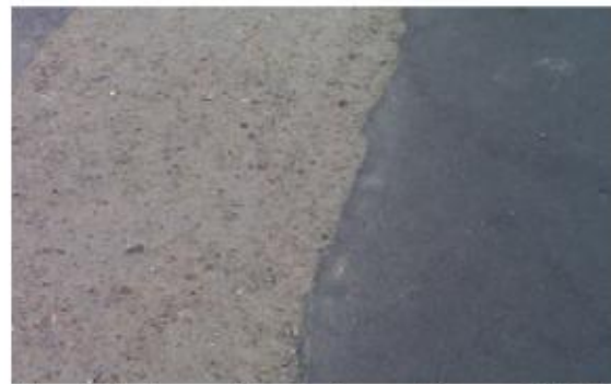
Figure 19 – Comparaison de deux revêtement de trottoir 1 heure après le coucher du soleil le 31 juillet 2011. Le stabilisé (à gauche) est nettement plus frais que l'asphalte (à droite), c'est leur différence de couleur
