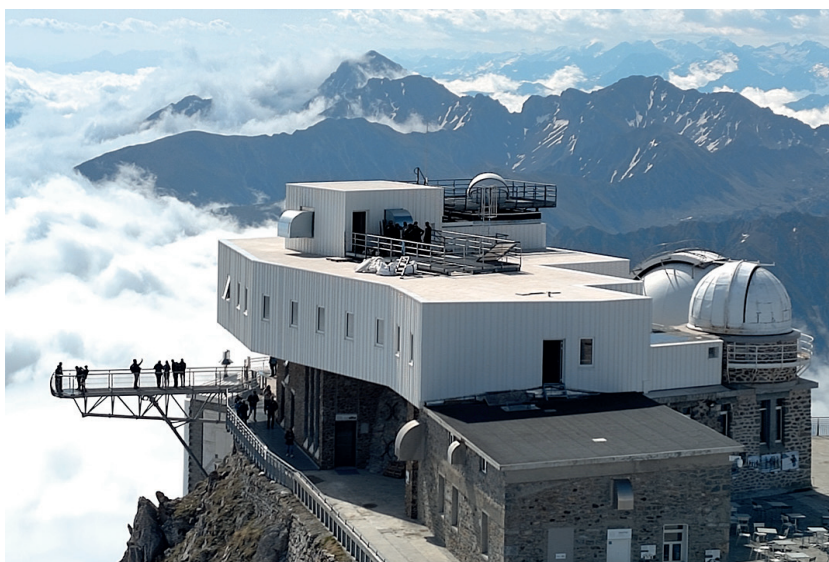
La plate-forme environnementale du Pic du Midi. © François GHEUSI
